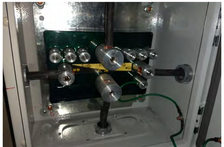
Instalación del producto COPLAGAUSS CON BARRA DE UNIÓN INTEGRADA FG-CG-12BU, es el dispositivo que conecta el conductor del electrodo de acoplamiento a tierra con sus conectores laterales para disipar, en forma de calor hasta el 80% de una corriente de falla o la actividad constante de eventos tales como turbulencias electromagnéticas o corrientes indeseables.
